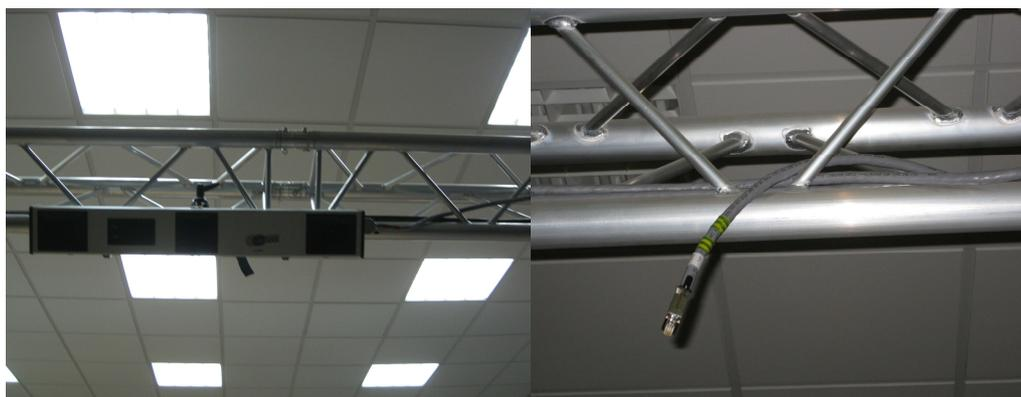
Fig 2 : Emplacement d'une barrette de caméra avec son câble
